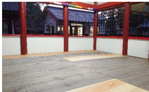
拝殿 腰板新調・床板腐食箇所取替
