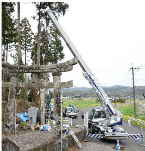
大きな重機を使つての設置工事
